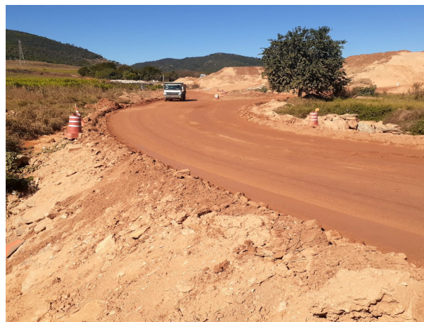
Foto 30: Passagem Pantaleão finalizada (24/05/2021)
