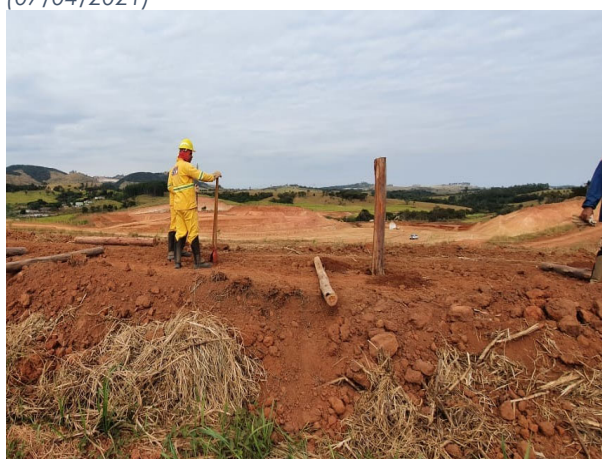
Foto 3: Cercamento da área do canteiro industrial (20/05/2021)
