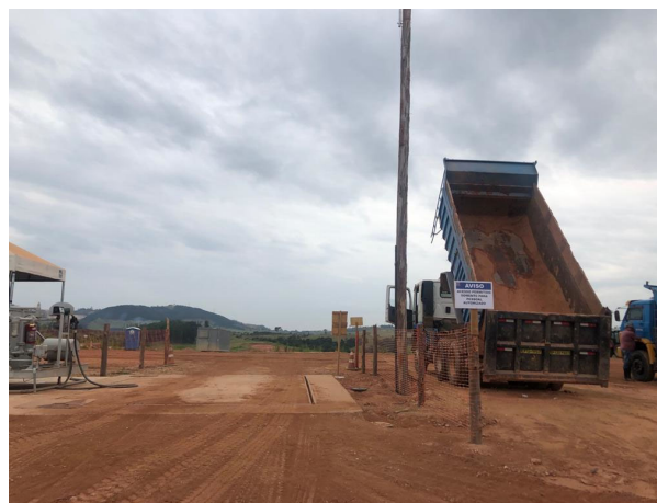
Foto 2: Estruturas no Canteiro Industrial (20/04/2021)
