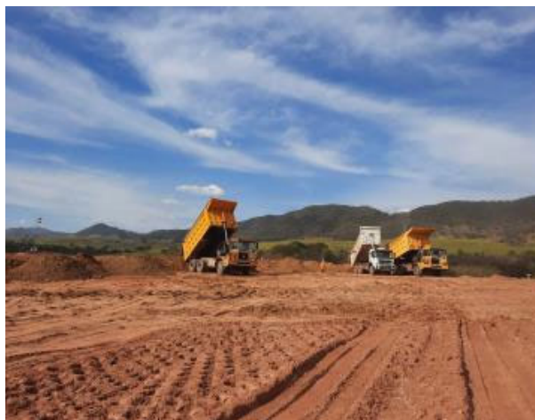
Foto 9: Descarte, espalhamento e compactação de material – Bota-Fora MD (14/05/2021)
