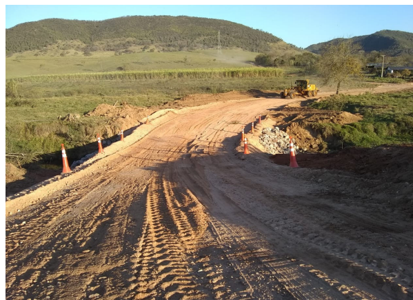
Foto 28: Passagem Pantaleão finalizada (01/09/2020)
