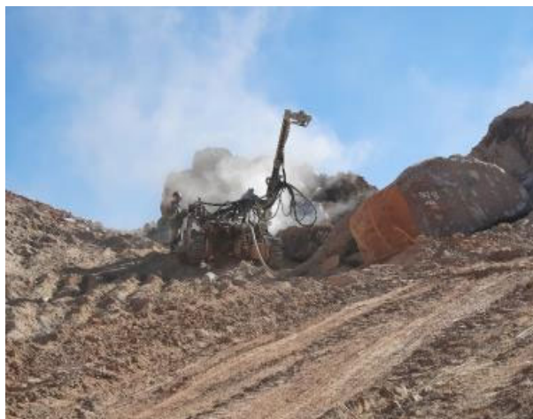
Foto 5: Perfuração em rocha para a atividade de desmonte de rocha (galeria) (27/05/2021)
