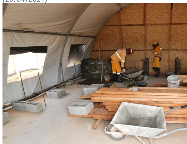
Foto 4: Construção da estrutura / escritório no canteiro industrial (20/05/2021)
