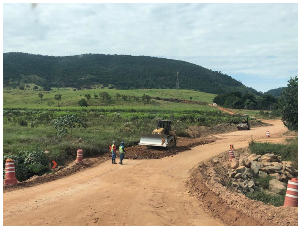
Foto 29: Passagem Pantaleão em manutenção devido aos eventos de chuva (06/04/2021)
