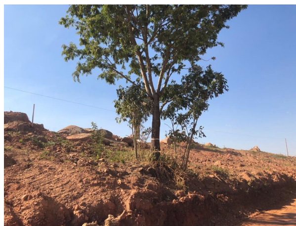
Foto 22: Verificação da demarcação das parcelas – 20/05/2021
