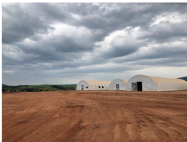
Foto 1: Estruturas no Canteiro Industrial (07/04/2021)
