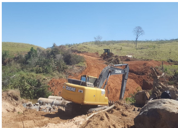
Foto 27: Passagem Pantaleão em execução (28/08/2020)
