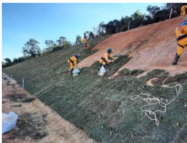
Foto 7: Plantio de grama (cobertura de talude) no vertedouro (18/05/2021)
