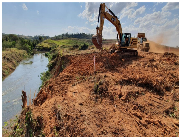
Foto 23: Passagem em execução (01/09/2020)
