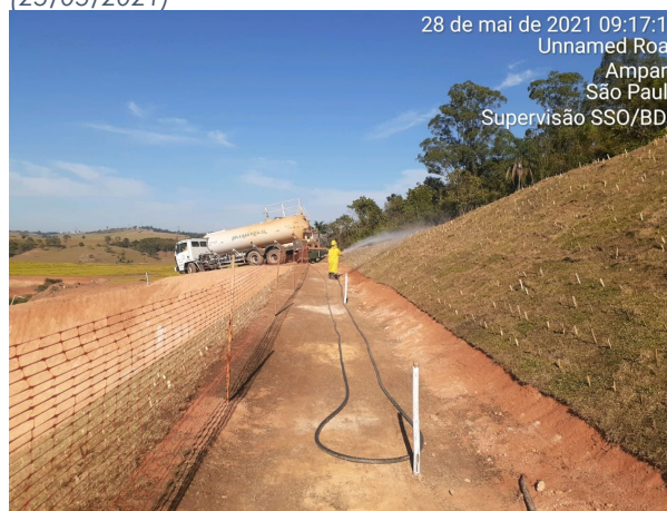
Foto 8: Umectação (caminhão pipa) da grama – cobertura do talude (28/05/2021)
