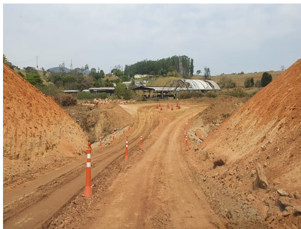
Foto 25: Passagem molhada do Camanducaia finalizada (16/09/2020)
