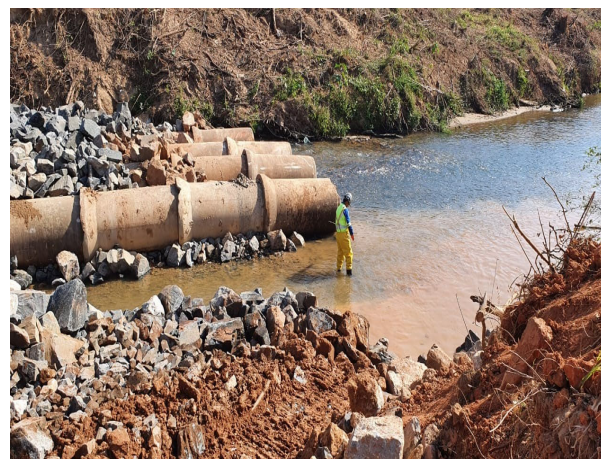
Foto 24: Passagem em execução (02/09/2020)
